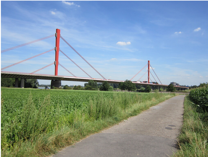
Rheinbrücke der Autobahn A 42 bei Baerl (2012) Fotograf/Urheber: Claus Weber
