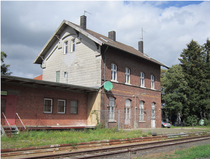
Empfangsgebäude des Bahnhofs Walheim in Aachen (2011) Fotograf/Urheber: Claus Weber
