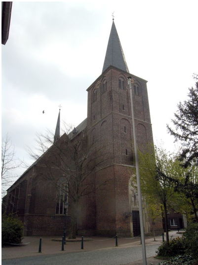
St. Maria Magdalena in Sonsbeck mit dem Hauptportal und dem nördlichen Seitenschiff (2008) Fotograf/Urheber: Biologische Station im Kreis Wesel e.V.
