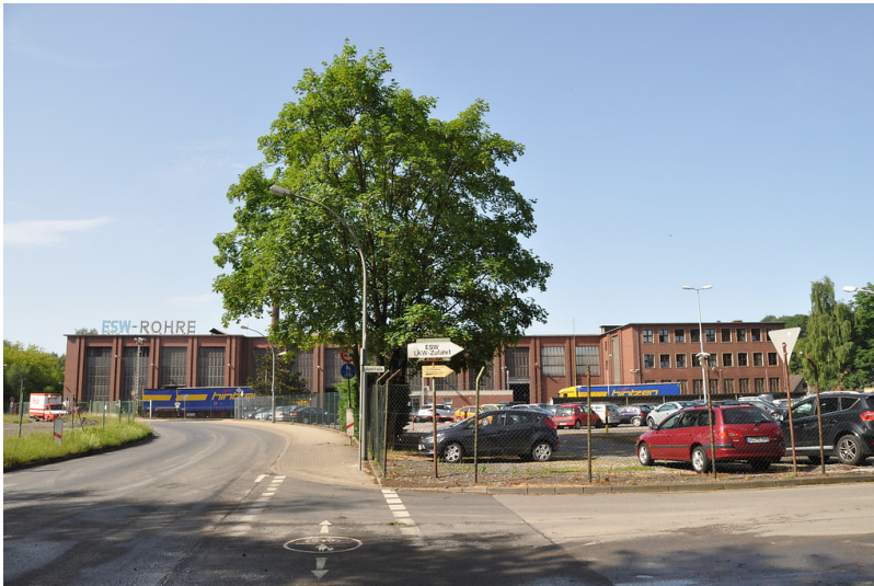
Produktionsgebäude der ESW-Röhrenwerke GmbH in Eschweiler-Aue (2014) Fotograf/Urheber: Fine Tonhauser
