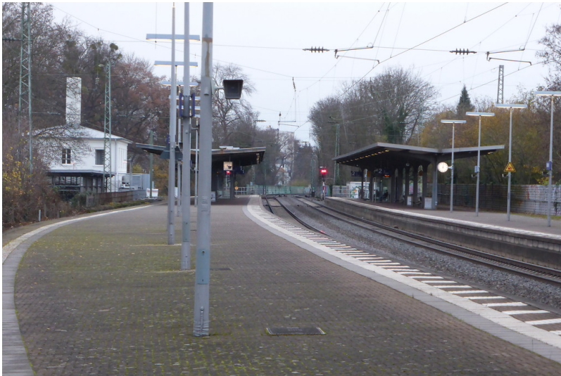
Bahnsteige des Personenbahnhofs Brühl (2014) Fotograf/Urheber: Stollenwerk, Anne
