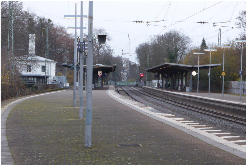
Bahnsteige des Personenbahnhofs Brühl (2014) Fotograf/Urheber: Stollenwerk, Anne
