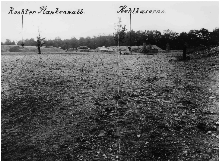
Fort X nach der Schleifung um 1920 Fotograf/Urheber: Arbeitsgemeinschaft Festung Köln e.V.
