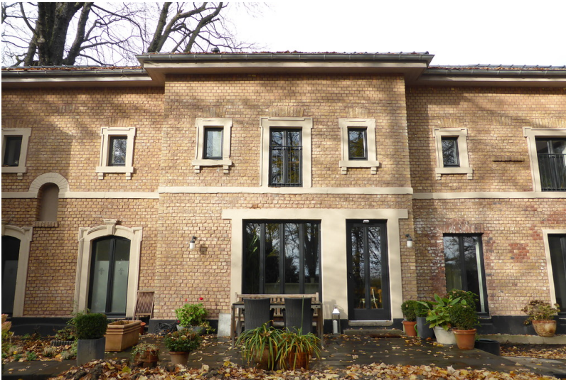
Trafohaus am Bahnhof Kierberg in Brühl von der dem Gleis abgewandten Seite aus gesehen Fotograf/Urheber: Stollenwerk, Anne
