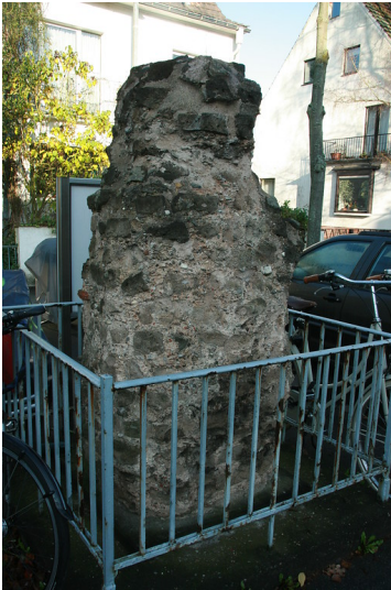
Pfeilerstumpf der römischen Wasserleitung an der Berrenrather Straße in Köln-Sülz (2014). Fotograf/Urheber: Hannelore Rose
