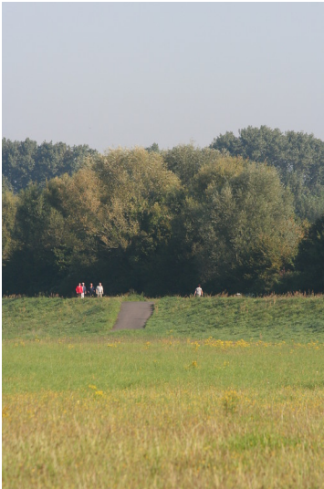
Rheindamm Flittard (2014) Fotograf/Urheber: Hannah Brüggemann
