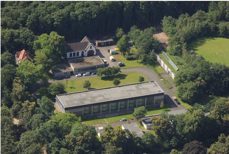
Luftbild der historischen Gebäude und der neueren Halle des Wasserwerks Hochkirchen in Köln-Raderthal (2014). Fotograf/Urheber: RheinEnergie
