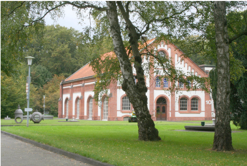
Das Wasserwerk in Köln-Westhoven (2014). Fotograf/Urheber: Hannah Brüggemann
