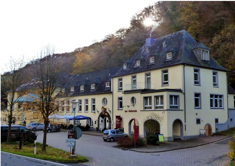
Bad Tönisstein, Blick auf die ehemalige Hofmeisterei, das heutige Seniorenheim (2014). Fotograf/Urheber: Maier, Christian
