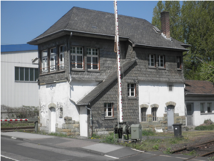
Das Stellwerk Tannenbergstraße in Bergisch Gladbach von Südwesten (2013) Fotograf/Urheber: Klostermann, Thomas
