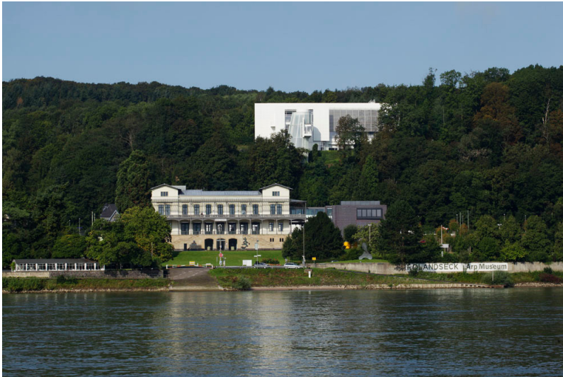
Das Empfangsgebäude des Bahnhofs Rolandseck von der rechten Rheinseite aus gesehen (2014) Fotograf/Urheber: Ulrich Pfeuffer
