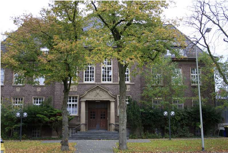
Das ehemalige Rathaus an der Frankfurter Straße in Voerde. Heute wird es als Seniorenheim genutzt (2014). Fotograf/Urheber: Siewers, Johanna
