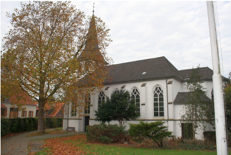
Evangelische Kirche an der Dammstraße in Götterswickerhamm (2014). Fotograf/Urheber: Siewers, Johanna
