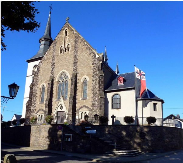
Südansicht der Katholischen Pfarrkirche "St. Lubentius" in Andernach-Kell (2014) Fotograf/Urheber: Maier, Christian
