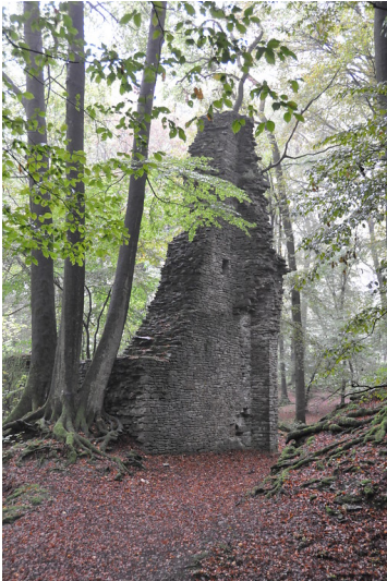
Reste der ehemaligen Hauptburg Neuenberg, Eingang zur Burg/Torbau (2014) Fotograf/Urheber: König, Julia
