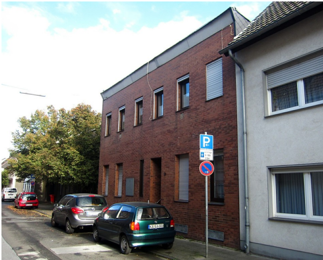
Wohnhaus in der Klever Straße 30. Hier befand sich die ehemalige Synagoge der jüdischen Gemeinde in Hüls (2014). Fotograf/Urheber: Knöchel, Franz-Josef
