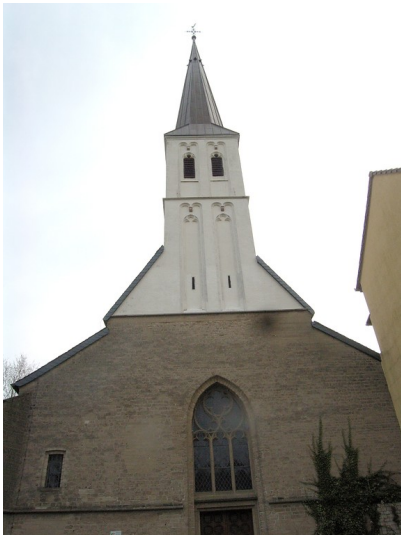
Wallfahrtskapelle St. Gerebernus in Sonsbeck mit weißem Turm über dem Sansteingebäude von der Portalseite aus gesehen (2008) Fotograf/Urheber: Biologische Station im Kreis Wesel e.V.
