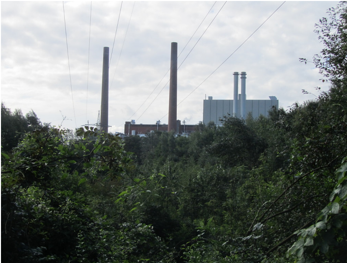
Betriebsgebäude und Schornsteine der Brikettfabrik Frechen (2014) Fotograf/Urheber: Schmitz, Nicole
