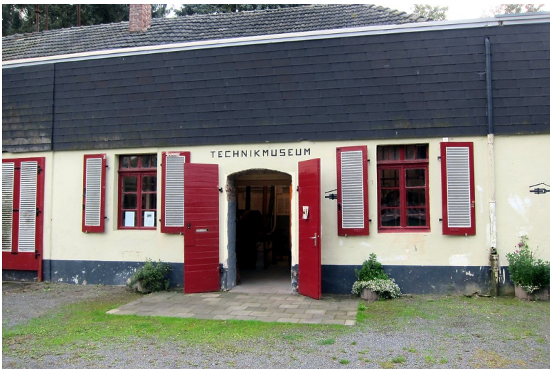
Eingangsbereich des Technikmuseums Bad Bodendorf (2014) Fotograf/Urheber: Knieps, Elmar
