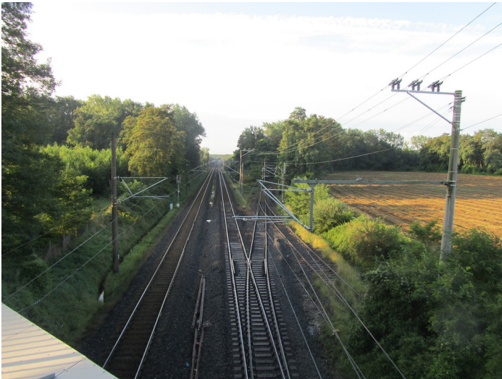
Trasse der Nord-Süd-Kohlenbahn bei Frechen (2014) Fotograf/Urheber: Schmitz, Nicole
