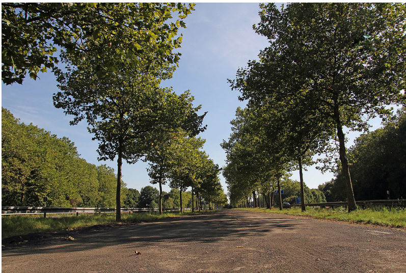
Trasse der Bundesautobahn A 555 („Diplomatenrennbahn“) zwischen Autobahnkreuz Köln-Süd und Verteilerkreis Köln (2012). Fotograf/Urheber: Superbass
