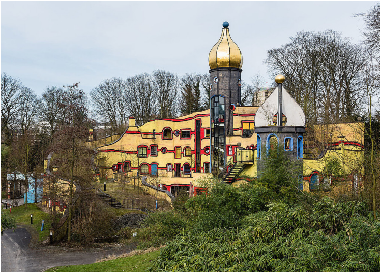
Das "Ronald McDonald-Haus" von Friedensreich Hundertwasser im Essener Grugapark (2016). Fotograf/Urheber: Tuxyso
