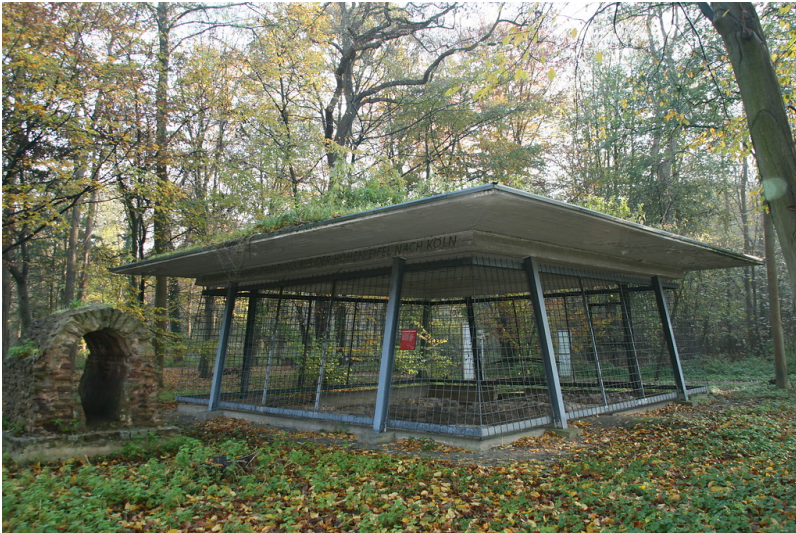
Schutzbau des Absetzbeckens und daneben ein versetztes Teilstück der römischen Wasserleitung in Köln-Sülz (2014). Fotograf/Urheber: Hannelore Rose
