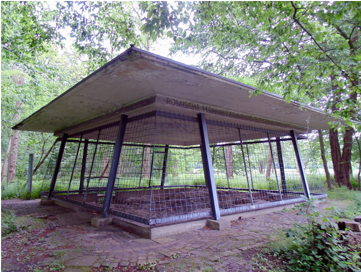
Der Schutzbau über dem ehemaligen Absetzbecken der römischen Eifelwasserleitung in Köln-Sülz. Es befindet sich heute auf dem Gebiet des äußeren Grüngürtels (2021). Fotograf/Urheber: Katharina Grünwald
