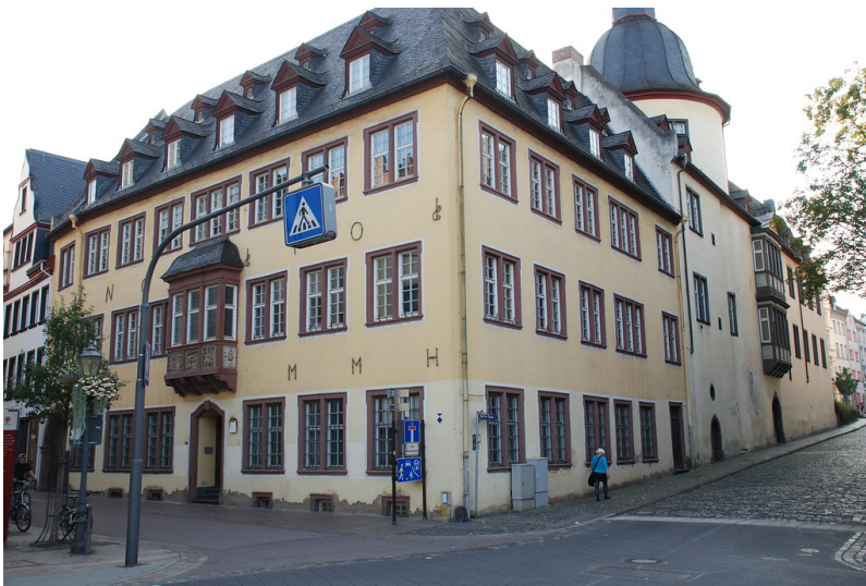
Das Dreikönigenhaus in der Koblenzer Altstadt (2014). Fotograf/Urheber: Alexandra Janzen
