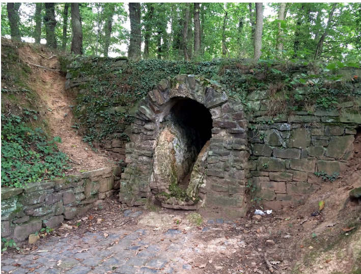
Reste des ehemaligen Römerkanals bei Euskirchen-Kreuzweingarten (2014) Fotograf/Urheber: Wall, Andreas
