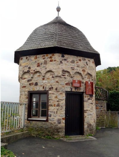
Stadtmauerturm "Schiffchen" der zur ehemaligen Stadtmauer in Montabaur gehört (2014) Fotograf/Urheber: Wörsdörfer, Niklas
