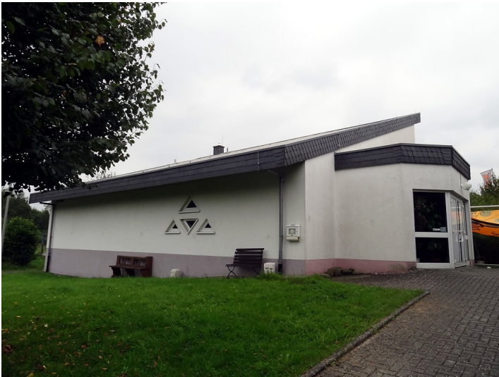
Gebäude des Amateurtheaters "Oase" in Montabaur (2014) Fotograf/Urheber: Wörsdörfer, Niklas
