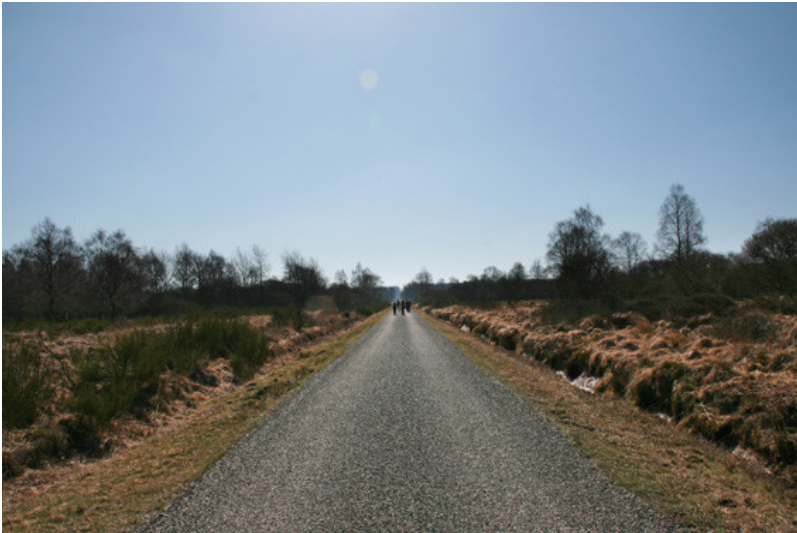
Befestigter Wirtschaftsweg im Hohen Venn nordwestlich von Monschau (2010) Fotograf/Urheber: Liebermann, Loni/Euregio im Bild
