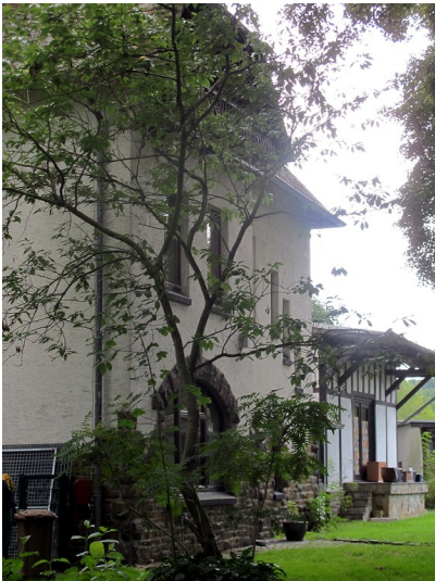
Bahnhof Oberlahr, das Bahnhofsgebäude (2014). Fotograf/Urheber: Jan Grendel
