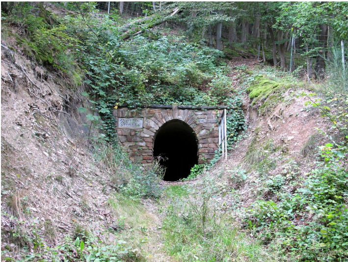
Otto-Stollen Horhausen, der Stolleneingang in den Berg (2014). Fotograf/Urheber: Jan Grendel
