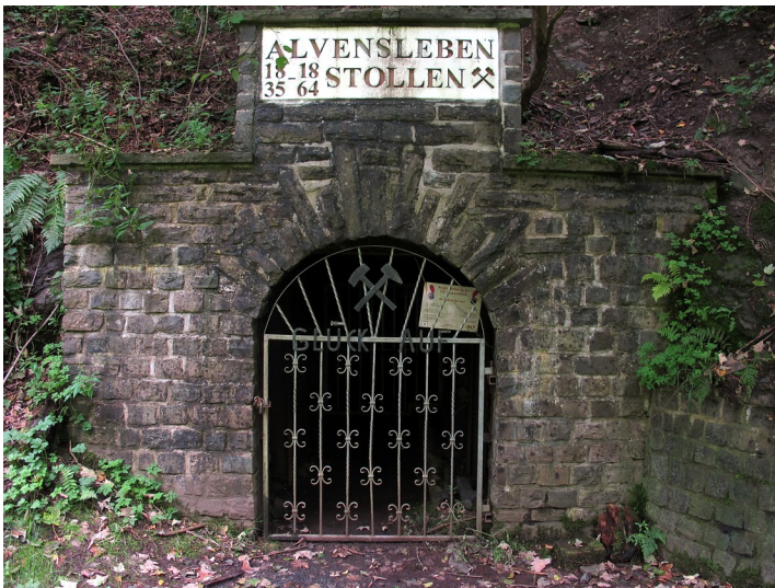
Alvensleben-Stollen bei Burglahr, Blick auf den Eingang des Besucherstollens (2014). Fotograf/Urheber: Jan Grendel
