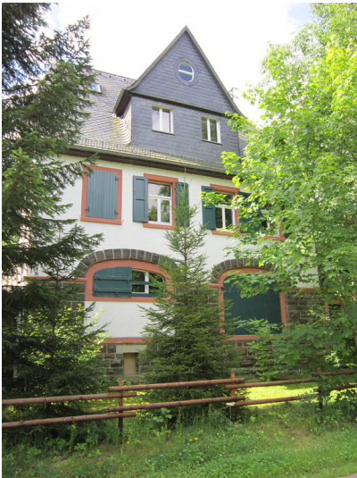
Bahnhof Kronenburg (2012) Fotograf/Urheber: Claus Weber
