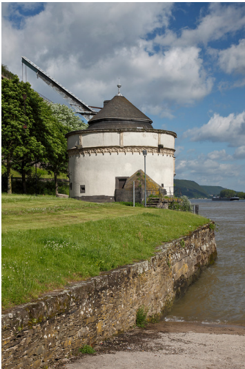
Andernach, "Alter Krane" (2012) Fotograf/Urheber: Klaes-Bildarchiv / M. Monreal
