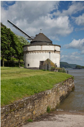
Andernach, "Alter Krane" (2012) Fotograf/Urheber: Klaes-Bildarchiv / M. Monreal
