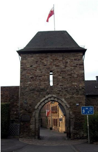
Das Adenbachtor im Nordwesten der Ahrweiler Stadtbefestigung von der Außenseite aus gesehen (2014) Fotograf/Urheber: Vanessa Bindarra
