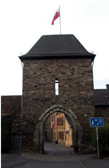
Das Adenbachtor im Nordwesten der Ahrweiler Stadtbefestigung von der Außenseite aus gesehen (2014) Fotograf/Urheber: Vanessa Bindarra
