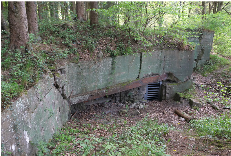
Bild 1: Der 'Westwall'-Bunker Nr. 59 befindet sich am Ortsrand von Simonskall und zählt zum Typ Regelbau Nr. 10 (2015). Fotograf/Urheber: Frank Möller
