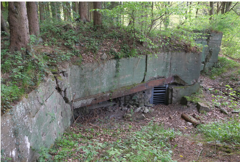
Bild 1: Der 'Westwall'-Bunker Nr. 59 befindet sich am Ortsrand von Simonskall und zählt zum Typ Regelbau Nr. 10 (2015). Fotograf/Urheber: Frank Möller
