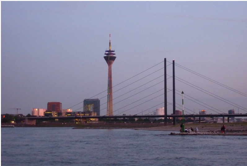
Die Rheinkniebrücke in Düsseldorf in der Nordansicht (2012). Im Hintergrund sind der Fernsehturm, das "Stadttor" und Gebäude des Medienhafens zu erkennen. Fotograf/Urheber: Suzan Leblebici
