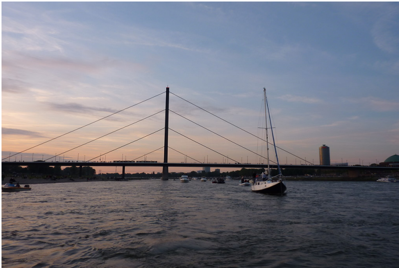
Die Oberkasseler Brücke in Düsseldorf in der Südansicht Fotograf/Urheber: Leblebici, Suzan
