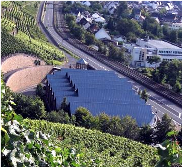
Das Archäologische Museum "Römervilla" am Silberberg bei Ahrweiler mit seiner markanten Dachlandschaft (2014) Fotograf/Urheber: Bindarra, Vanessa
