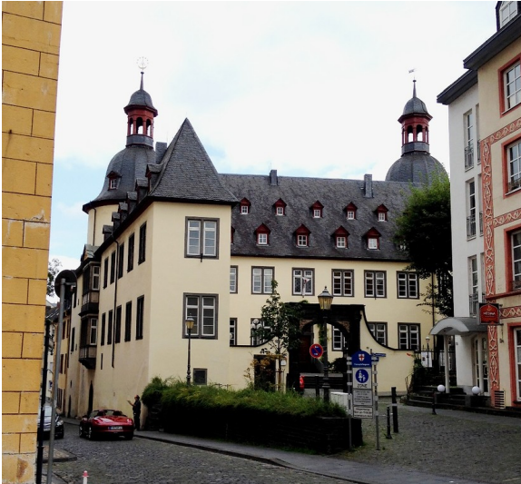
Historischer Gebäudekomplex "Auf der Danne" in Koblenz (2014)
