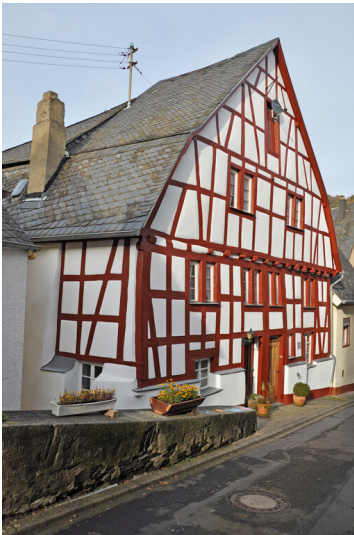
Fachwerk-Doppelhaus in der Römerstraße 6-8 in Briedel Fotograf/Urheber: Arne Houben
