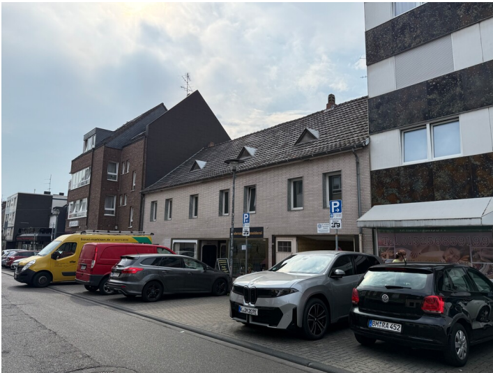
Wohnhaus am Standort der Blumentopffabrik Anton Firmenich (2026) Fotograf/Urheber: Nicole Schmitz
