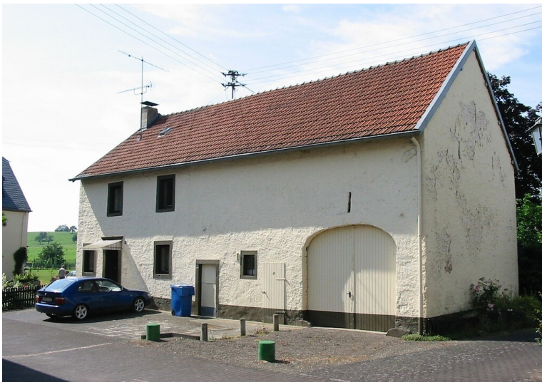
Das Gebäude Burgstraße 8 in Oberkail vor der Renovierung 2007, Ansicht von der Burgstraße aus (2006) Fotograf/Urheber: unbekannt
