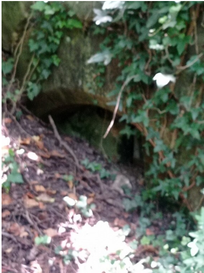
Poterne in der Schafgasse Fotograf/Urheber: KuLaDig-Projektteam Billigheim-Ingenheim
