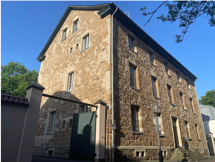
Das Zeughaus an der Zeughausstraße in Siegburg (2026). Heute ist hier die Engelbert-Humperdinck-Musikschule untergebracht. Fotograf/Urheber: Stadtbetriebe Siegburg AöR, Tourismusförderung
