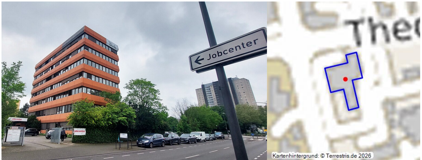
Der heutige Standort Porz des Kölner Jobcenters in Köln-Eil (Ansicht von der Theodor-Heuss-Straße, 2026); das Gebäude wurde ursprünglich als Zentrale der Computer- und Elektronikfirma Bull Deutschland AG erbaut und 1983 bezogen. Fotograf/Urheber: Franz-Josef Knöchel
