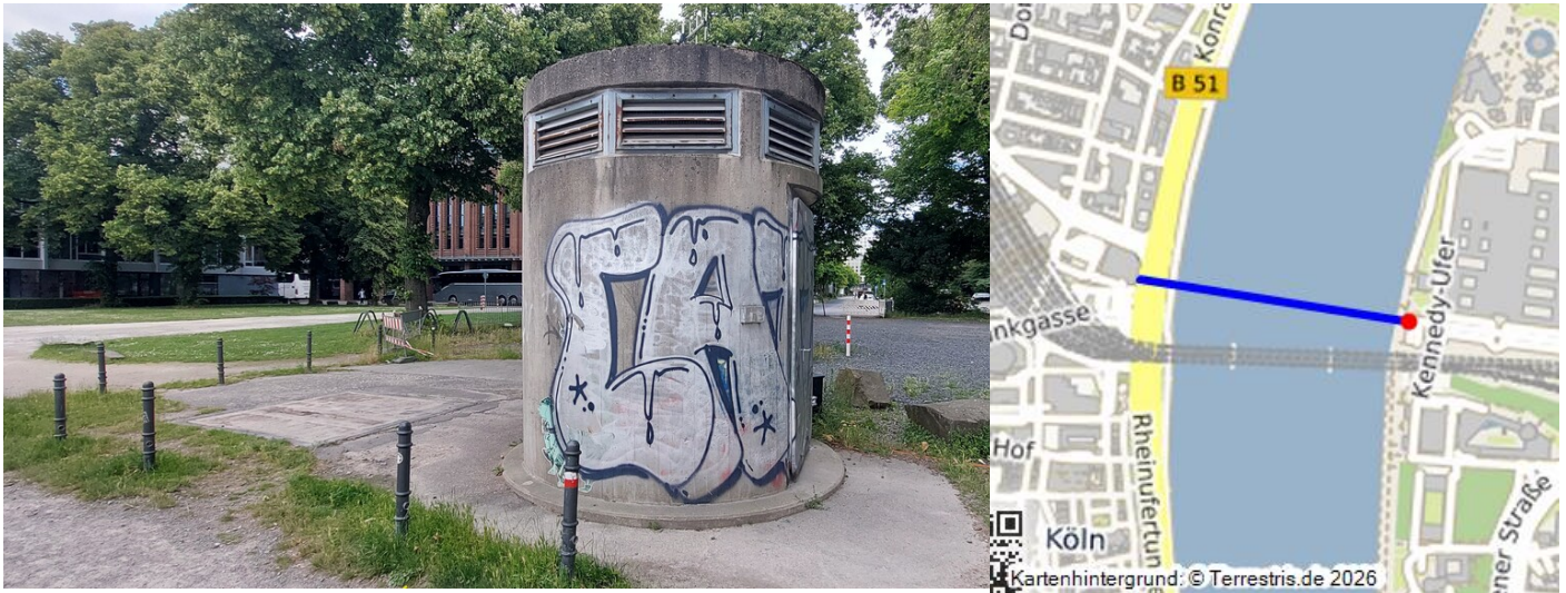
Das eher unscheinbare Türmchen am Deutzer Kennedyufer an der Hohenzollernbrücke ist der Eingang zu einem Fernwärmetunnel unter dem Rhein (2026). Fotograf/Urheber: Franz-Josef Knöchel
